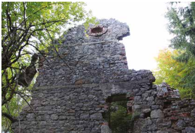
Ruševine nekoč mogočnega objekta mejne milice na Melišju, datiran z gradbenim načrtom z dne 12. junija 1933
